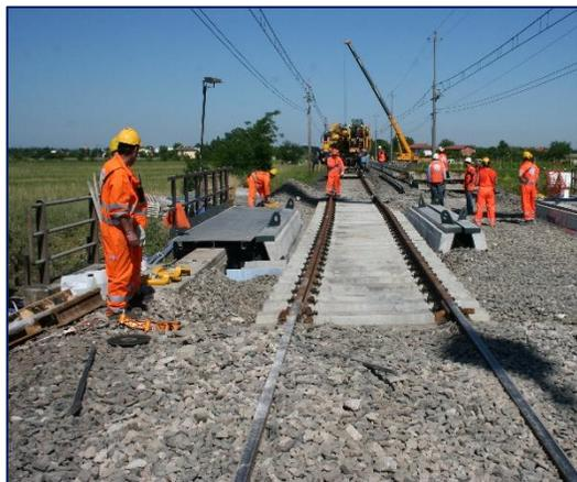
Rincalzatura e profilatura per una nuova livelletta
